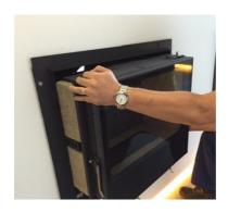
• Lorsque la chambre de combustion est sortie, le raccordement cheminée est visible. Il est possible de le retourner en retirant les 4 écrous et le disque défonçable au-dessus du manteau.
